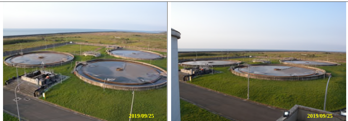
現場照片（二沉池設施）
