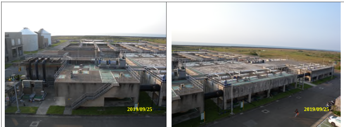
現場照片（進流站、初沉池設施）
