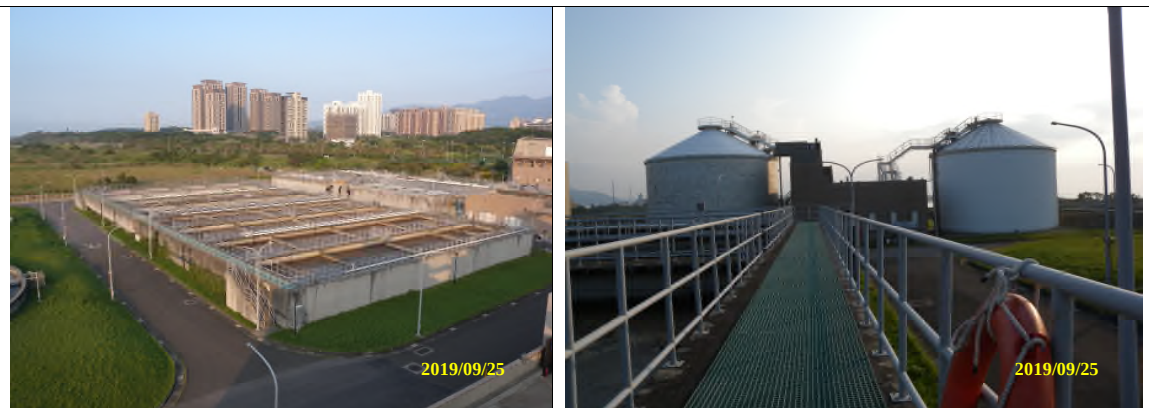
現場照片（生物處理設施）（污泥消化設施）
