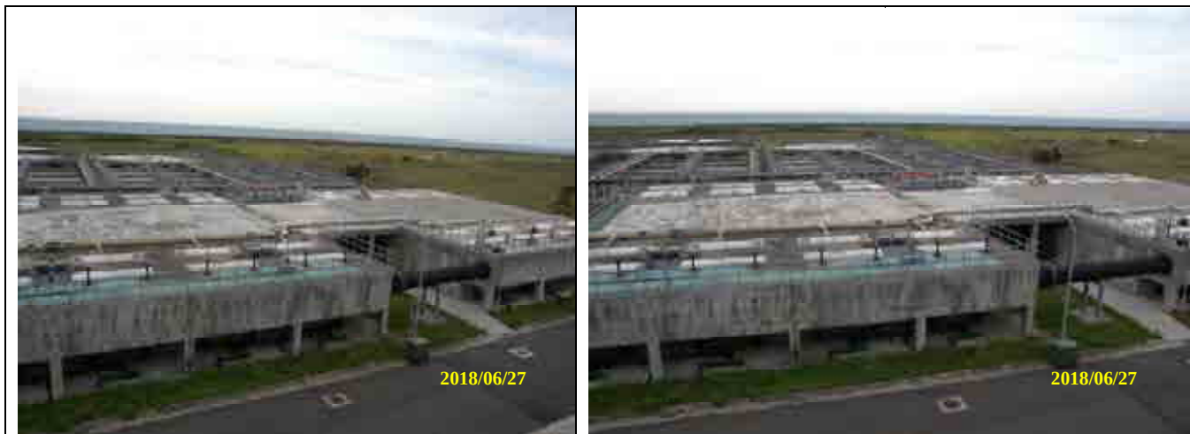
現場照片（初沉池設施）
