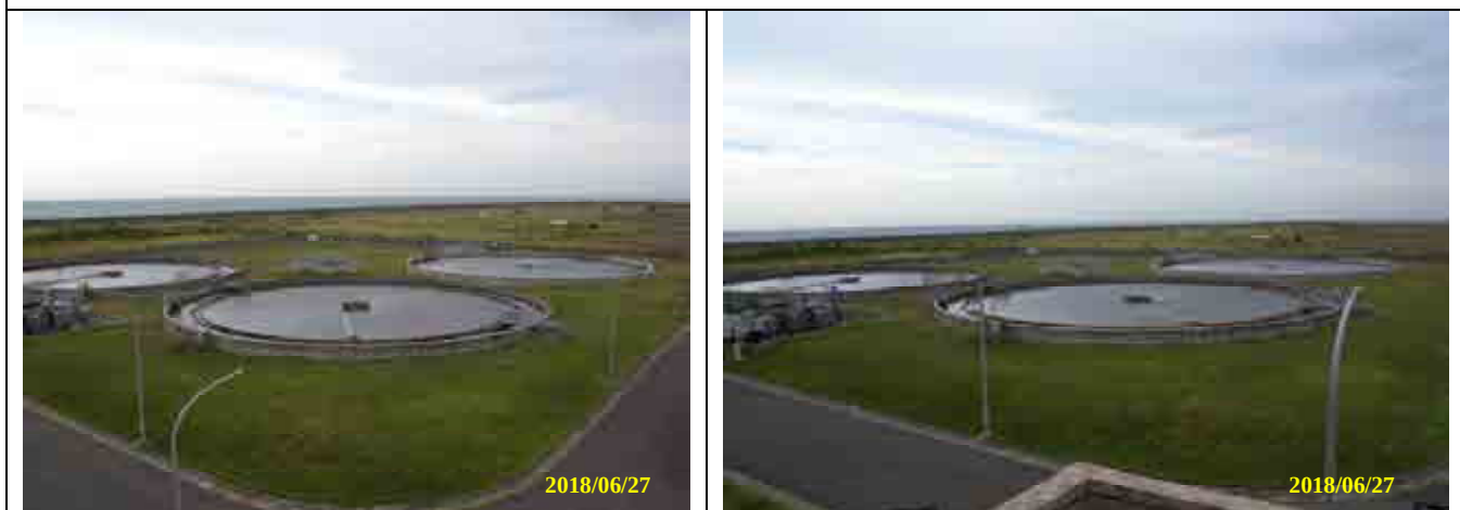
現場照片（二沉池設施）
