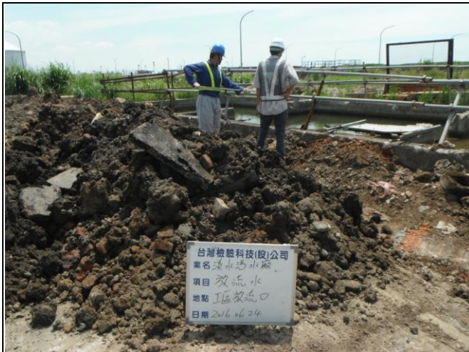
項目：放流水質 日期：105.05.20 地點：工區排水放流口
