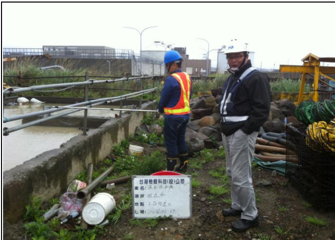
項目：放流水質 日期：105.03.09 地點：工區排水放流口
