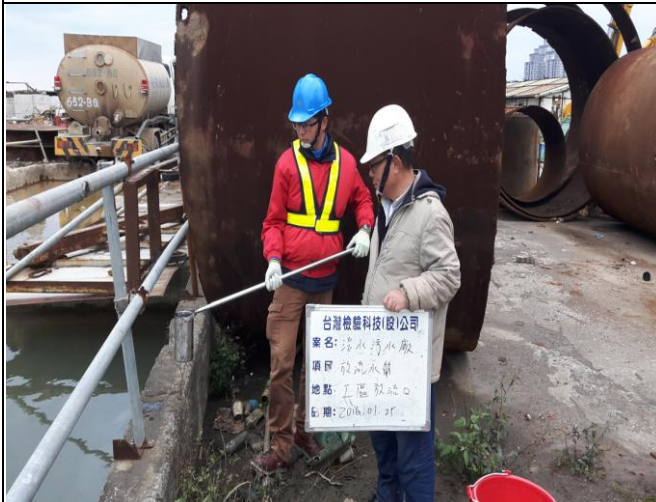
項目：放流水質 日期：105.01.25 地點：工區排水放流口
