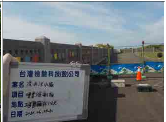
項目：噪音振動 日期：109.6.29-30 地點：工區圍籬外 1 公尺
