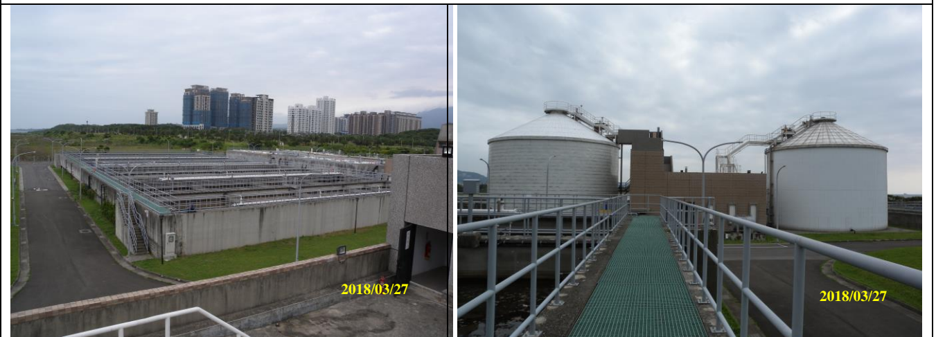
現場照片 (生物處理設施) (污泥消化設施)
