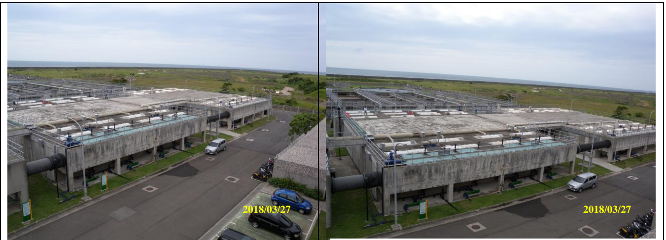
現場照片 (初沉池設施)
