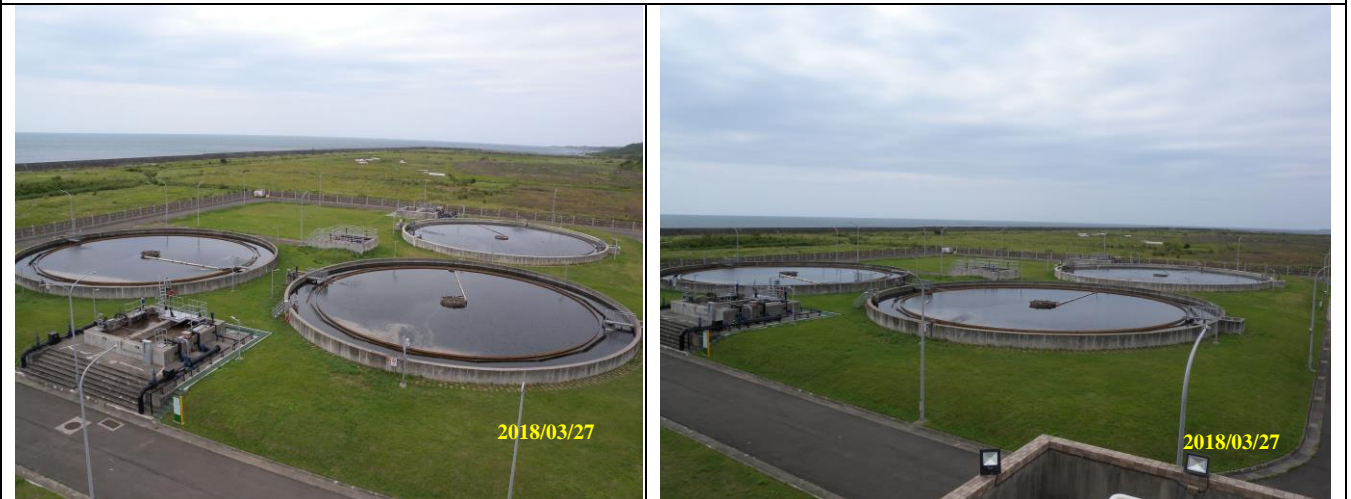
現場照片 (二沉池設施)
