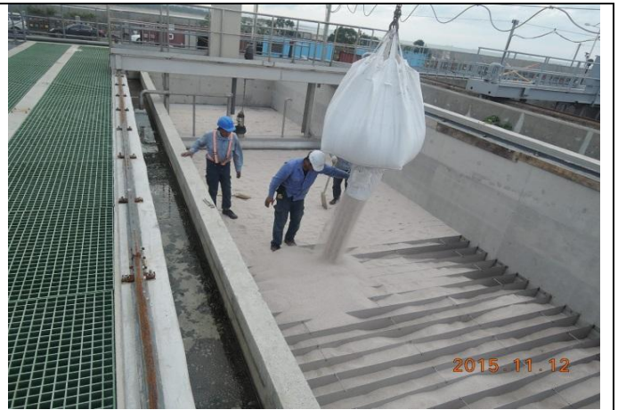
二期現場施工狀況(三級過濾設施)
