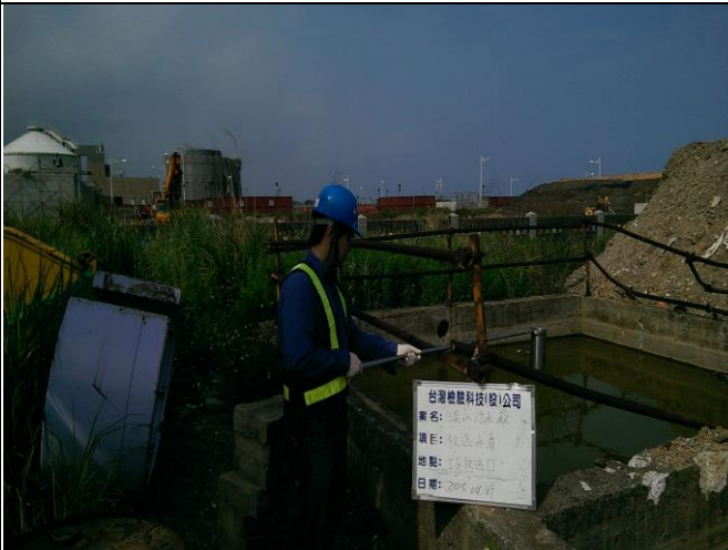
項目：放流水質 日期：104.04.29 地點：工區排水放流口
