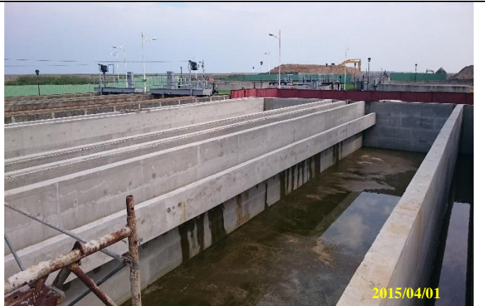
二期現場施工狀況(三級過濾設施)
