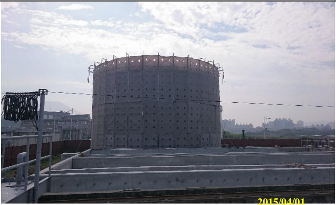
二期現場施工狀況(污泥消化設施)
