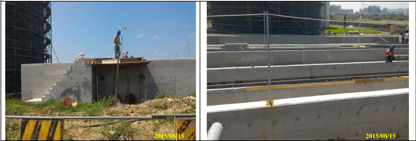
二期現場施工狀況(三級過濾設施)
