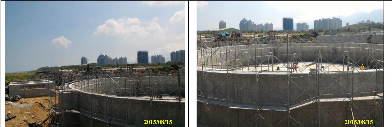
二期現場施工狀況(二沉池設施)
