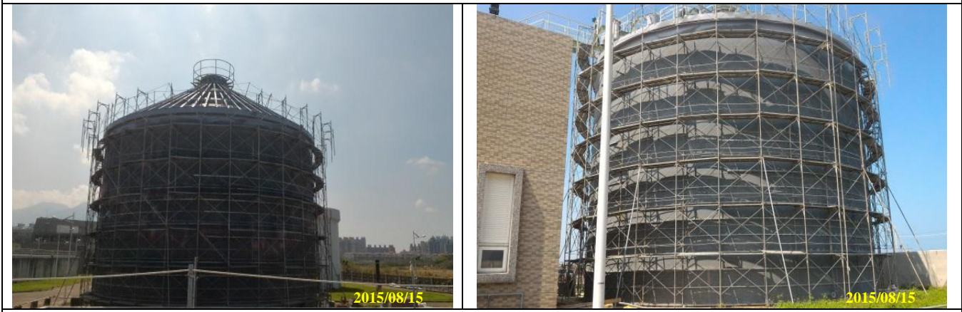
二期現場施工狀況(污泥消化設施)
